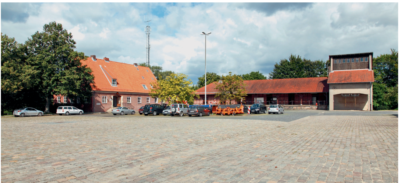
1 Autobahnmeisterei Bad Oldesloe, Blick über den Fahrhof auf Dienstgebäude und Gerätehalle.
