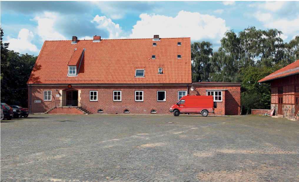
5 Dienstgebäude, Blick vom Fahrhof.
