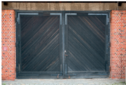
12 Eisenbeschlagene hölzerne Tore der Fahrzeughalle, gegen Verwitterung mit Motoröl imprägniert.
