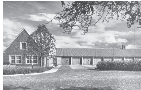
14 Ansicht der Straßenmeisterei Göttingen mit Dienstgebäude und Fahrzeughalle, bauzeitliche Aufnahme.
