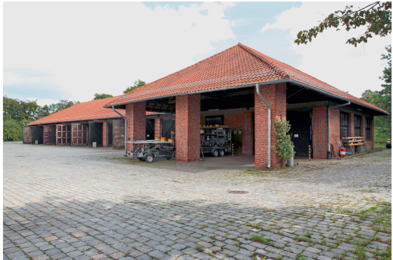
10 Fahrzeughalle mit Werkstatt, Blick vom Fahrhof.
