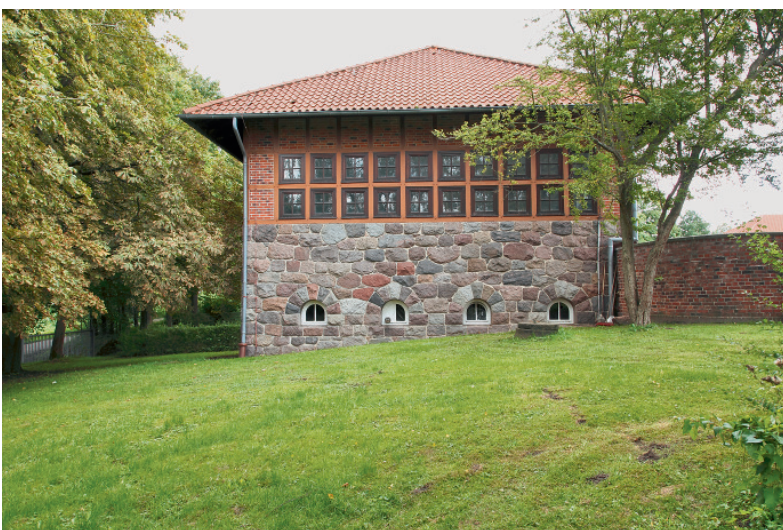
9 Gerätehalle, Seitenansicht mit feldsteinverkleidetem Stahlbetonkellerbauwerk.
