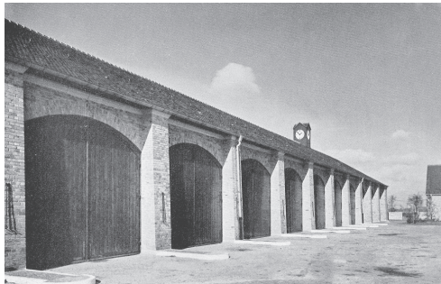
13 Fahrzeughalle der Straßenmeisterei Werder, bauzeitliche Aufnahme.
