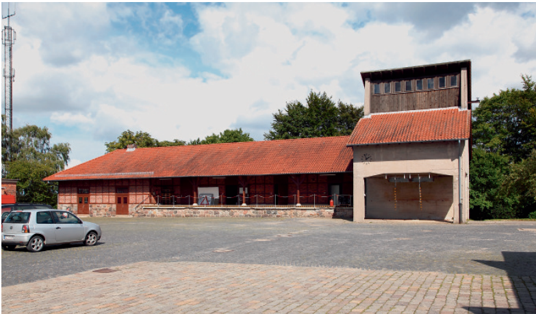
8 Blick auf Gerätehalle und Silobauwerk (errichtet um 1955) vom Fahrhof.
