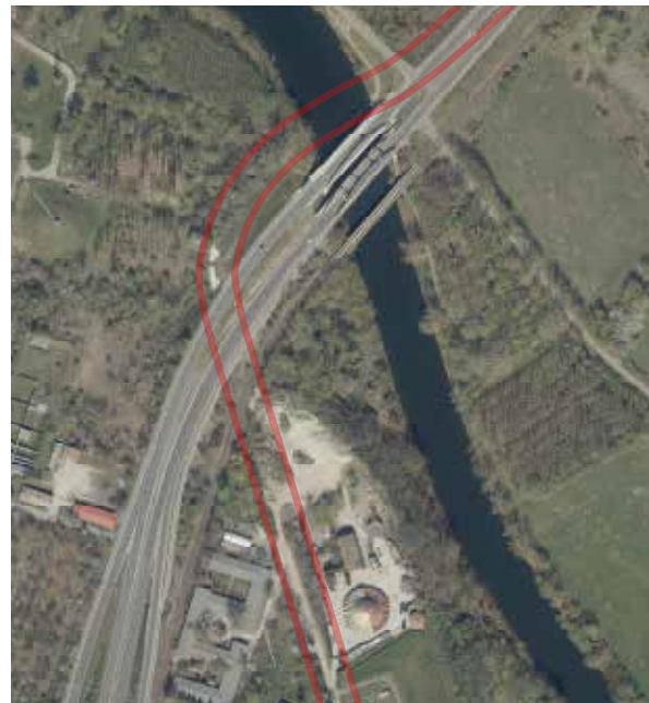
Digitales Orthofoto der Saaleüberbrückung mit Hervorhebung der alten Trasse. © GeoBasis-DE / LVerGeo LSA 2021
