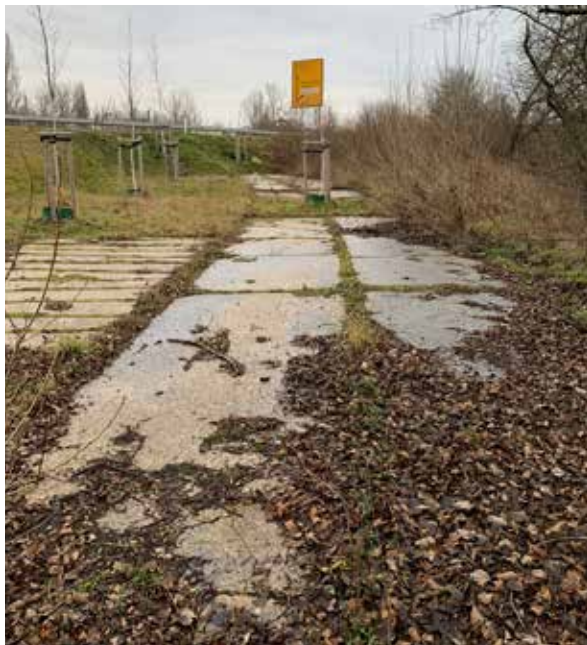
Blick über den alten Chaussee-Damm am Schkopauer Brückenkopf auf die neue Trasse der B91. © Foto: Holger Volk
